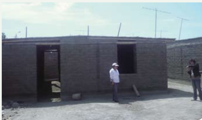
Exemple de construction faite de torchis antisismiques.
